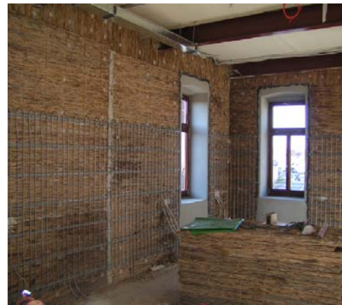
Placare cu trestie și sistem de încălzire montat
