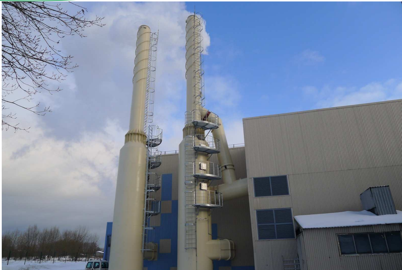
2 kondensatori 10 MW katliem
