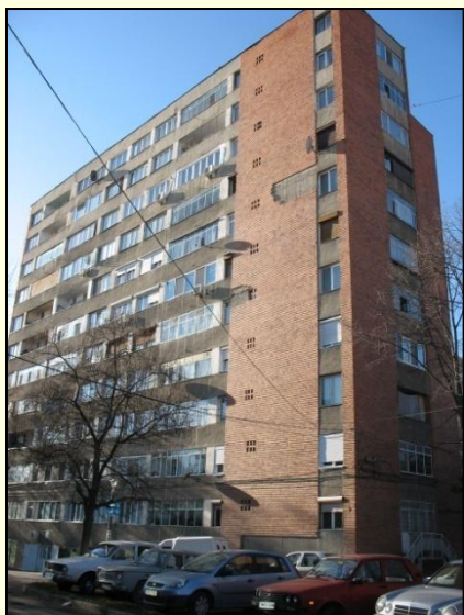
Înainte de reabilitare
