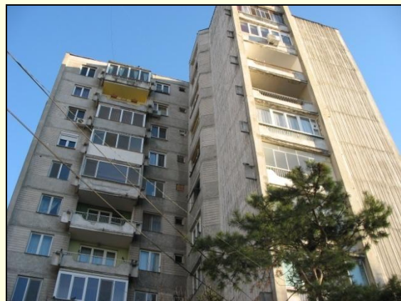
Înainte de reabilitare
