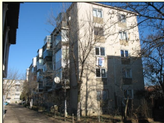
Înainte de reabilitare
